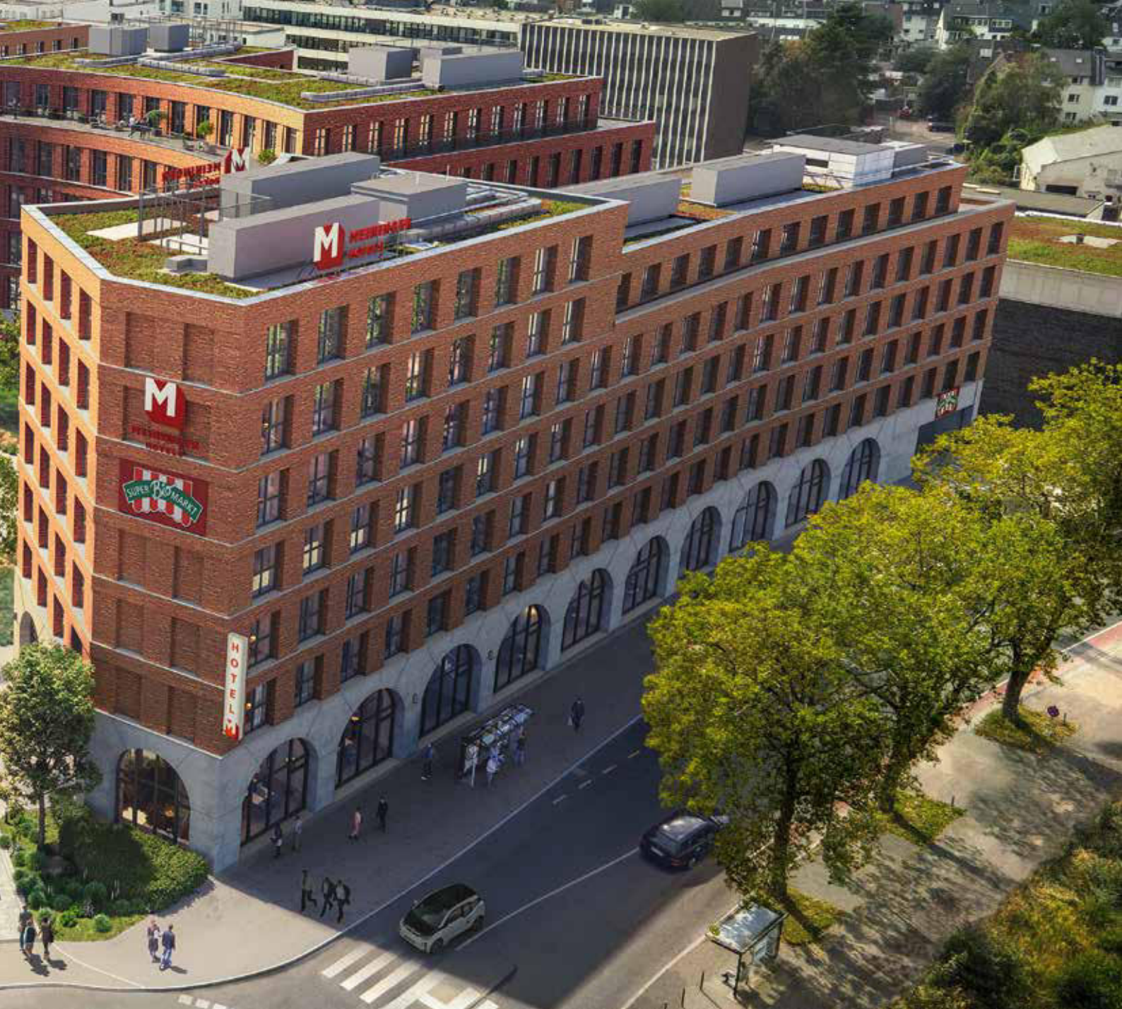
Das Ovum-Ensemble besteht aus vier Gebäuden.
